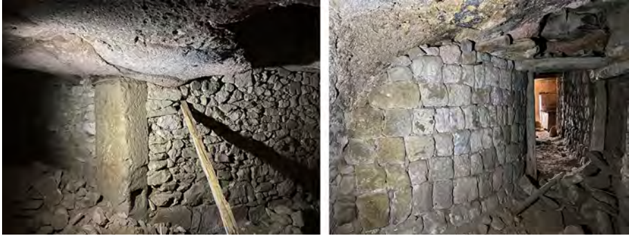
Şekil 11. Oyma ve yığma sistem birleşimi
