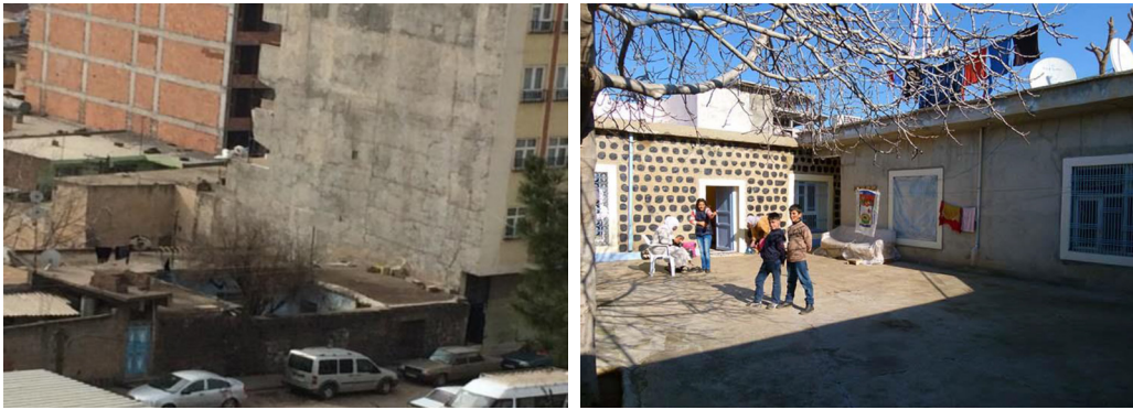
Şekil 9. Yüksek Katlı Betonarme Yapıların Bitişğinde Kalmış Avlulu Konut (Yazar, 2015).
