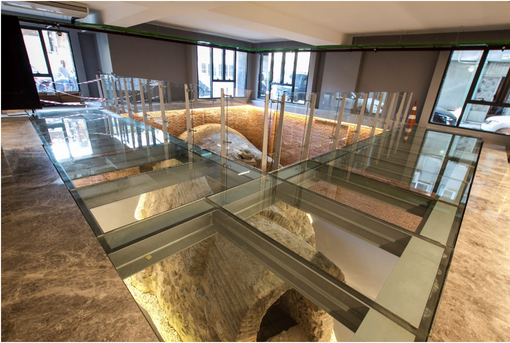
Şekil 37. 1020 ada 13 parseldeki su dolabı üzerindeki cam döşeme.
