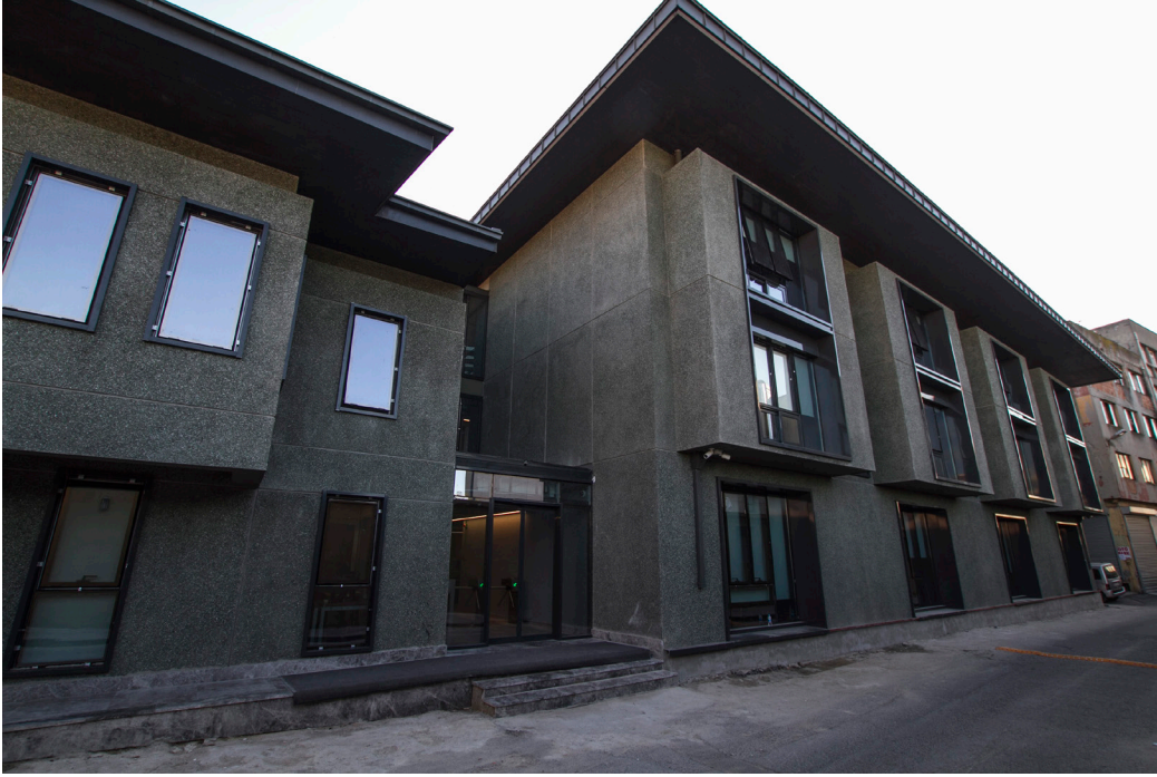
Şekil 38. 1020 ada 13 parsel kuzeydoğu cephesi – yenileme.
