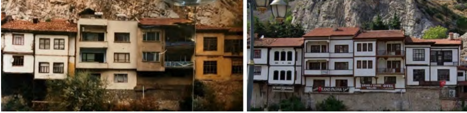
Şekil 23. Yalıboyu Cephesi, 1990lar -2021, Cephedeki yeni ve eski tüm yapılar son dönemdeki restorasyon uygulamaları ile aynı renge boyanmış ve bu restorasyon uygulamalarında aynı renk ve malzemeden doğramalar kullanılmıştır. (Sol, ODTÜ, Kültürel Miras Koruma Lisansüstü Programı, 1999 2000 Bahar Dönemi REST 507: Planning and Design in Urban Conservation, Amasya Hatuniye Mahallesi Koruma ve Sağlıklaştırma Projesi, Sağ, https://www.google.com/earth/ , 2021)
