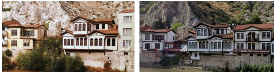
Şekil 21. Yalıboyu Cephesi, 1990s-2021, cephe ve malzeme özelliklerini koruyarak gerçekleştirilen müdahale örneği ile hemen yanındaki süreç içinde restorasyonlarla geleneksel cephe görseliyle taklit olarak değiştirilen yeni yapı örneği (Sol, ODTÜ, Kültürel Miras Koruma Lisansüstü Programı, 1999 2000 Bahar Dönemi REST 507: Planning and Design in Urban Conservation, Amasya Hatuniye Mahallesi Koruma ve Sağlıklaştırma Projesi, Sağ, https://www.google.com/earth/ , 2021)
