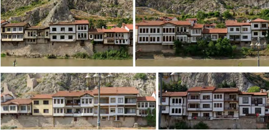
Şekil 11. Yalıboyu Cephesi, kütle özellikleri olarak uyumlu, cephe düzenleriyle uyumsuz yapılar/ müdahalelere örnekler ( https://www.google.com/earth/ , 2021)
