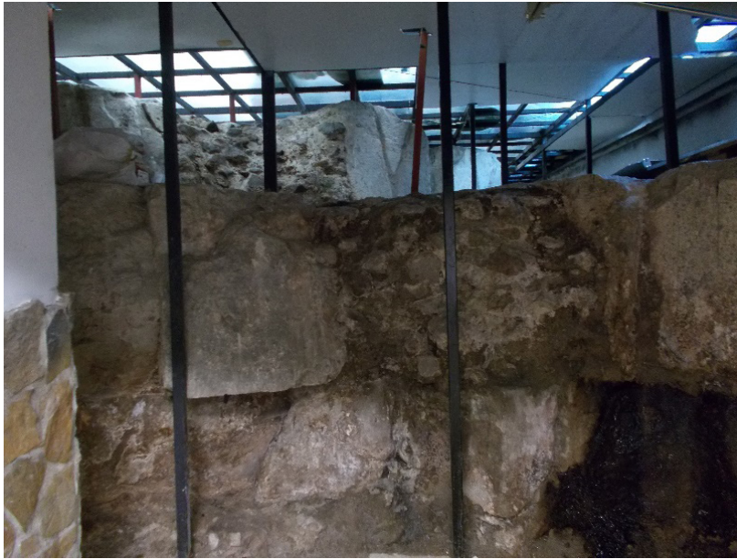
Şekil 23. İhsan Kayın Plaza’nın temel aşamasında çıkan Liman kalıntıları (Eti Akyüz Levi arşivi).
