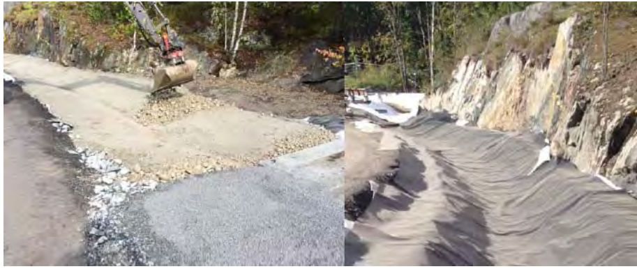
Şekil 12. Filtrelemeyi destekleyen dere yatağı yapım aşaması, Julsberg Projesi. (Kaynak: Rapp, 2019)
