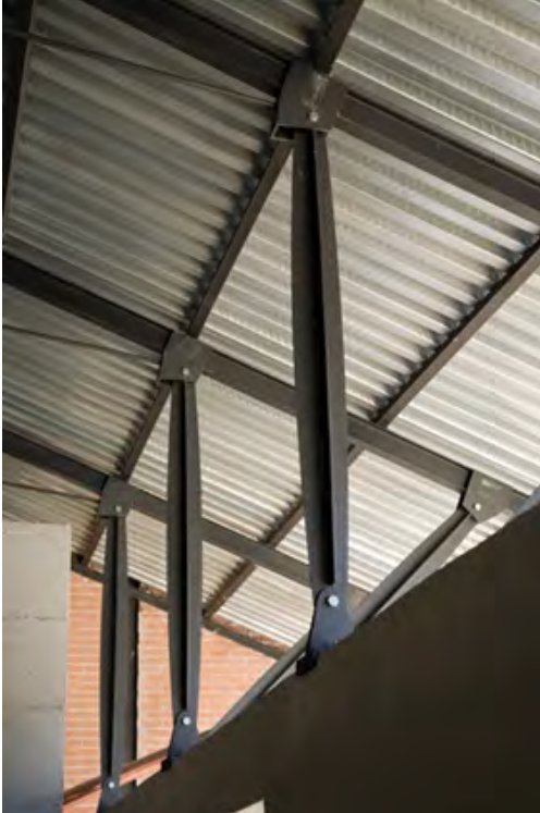
Şekil 9. Çatı çelik strüktürünü destekleyen payanda detayları.
