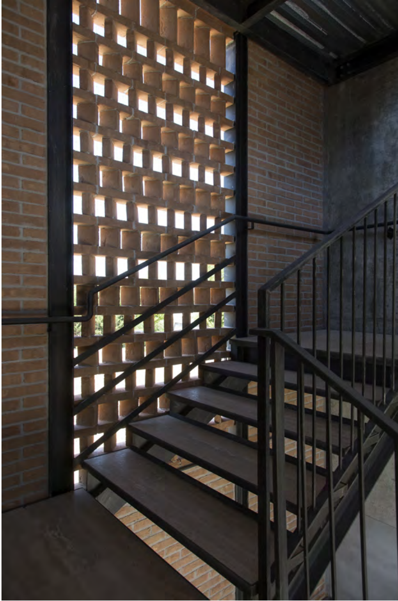
Şekil 16. Merdiven kulesi içindeki taşıyıcı olmayan tuğla “transenna” strüktürü.
