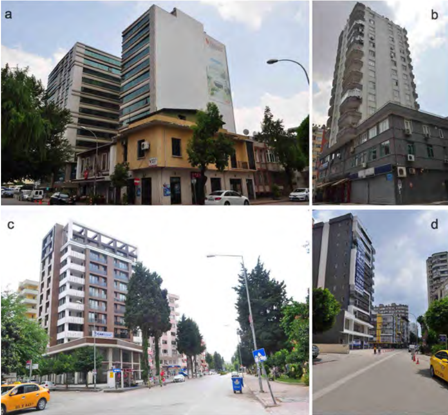
Şekil 15. (a) Alanda düşük yoğunluklu parsellerde inşa edilen iş merkezi; (b) Tip-7 apartmanları; (d) (c) Tip-8 apartmanları (Kişisel Arşiv)
