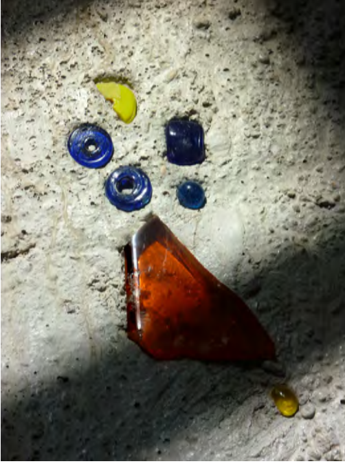
Şekil 17. Altarın arkasındaki adaklı şapelin detayı: Beton üzerine yerleştirilmiş renkli cam, çakılları temizlemek için su fişkırtılarak temizlenmiş.
