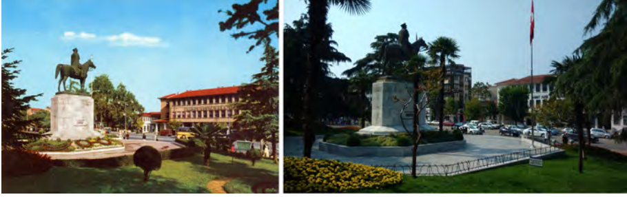
Şekil 27. Bursa Atatürk Anıtı ve Halkevi (Ahmet Vefik Paşa Tiyatrosu) binası karşı- lıklı olarak alanda yer almaktadır. 1960 ve 2021 yıllarına ait görseller. Alanın etrafın- daki yoğun yapılaşma görülürken Halkevi binasındaki mimari değişim görünmekte. (Kaynak: sol, SALT Araştırma Salt Arşivi; sağ, Okumuş Arşivi, 2021)
