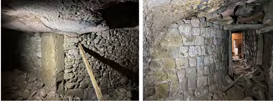
Şekil 11. Oyma ve yığma sistem birleşimi
