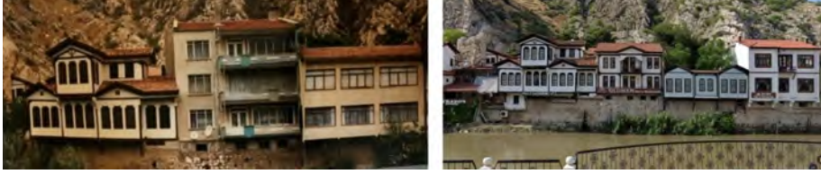
Şekil 9. Yalıbozu Cephesi, 1970ler- 2020, kütle özellikleri uyumsuz ve cephe özellikleri olarak uyumlu olarak “taklit” olarak geleneksel cephe görseliyle değiştirilen yeni yapı örnekleri (Sol: ODTÜ, Kültürel Miras Koruma Lisansüstü Programı, 1999 2000 Bahar Dönemi REST 507: Planning and Design in Urban Conservation, Amasya Hatuniye Mahallesi Koruma ve Sağlıklaştırma Projesi, Sağ: https://www.google.com/earth/ , 2021)
