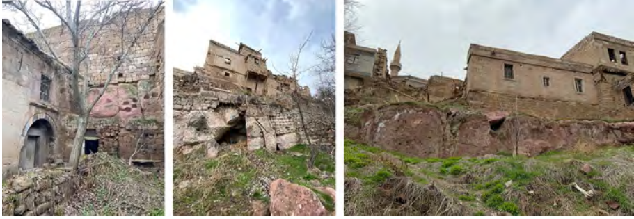
Şekil 9. Vekse kaya oyma ve yığma sistemlerin birlikte kullanımı
