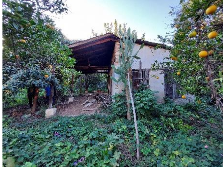
c. Gazipaşa Mahallesiinde bağ evi, 2022 (Aytaç TAŞKIN Arşivi)
