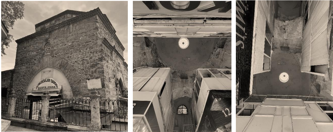
Şekil 8 Şengül Hamamı Günümüz Kullanım Durumu
