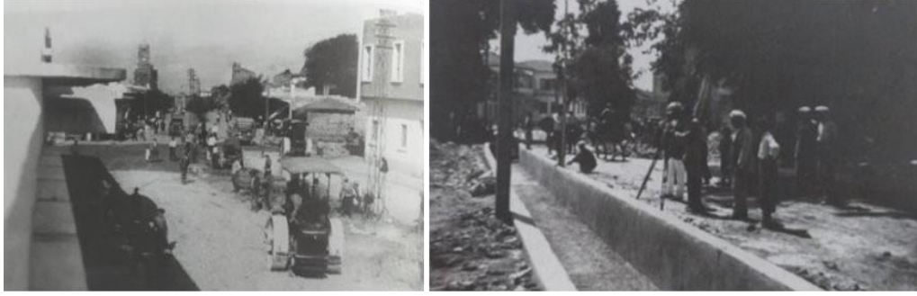
Şekil 8 Ali Çetinkaya Caddesi ve Atatürk Caddesi yol yapım çalışması 1943 (Çimrin, 2007)
