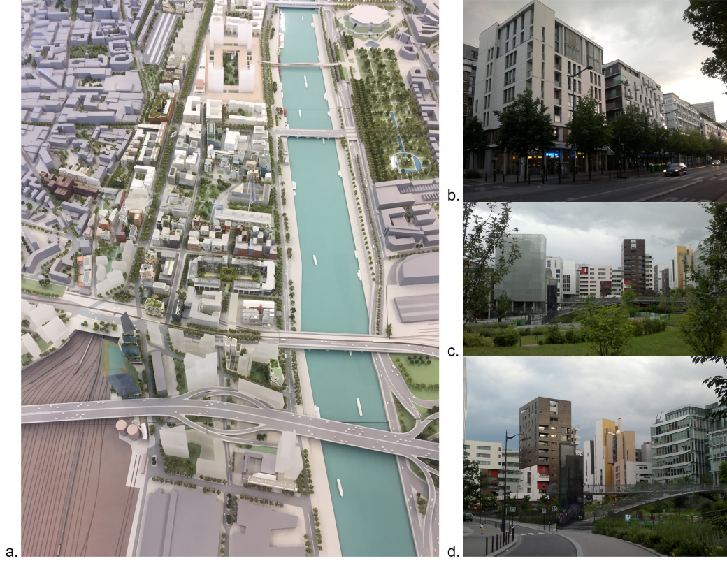
Şekil 15. a. Masséna kentsel gelişme alanı kentsel tasarım projesi uygulaması, maket fotoğrafı (Fotoğraf: Neris Parlak). b. Masséna kentsel gelişme alanında yeni yapılaşma: Seine cephesi (Fotoğraf: Cânâ Bilsel). c. Masséna kentsel gelişme alanında park çevresinde yeni yapılaşma (Fotoğraf: Cânâ Bilsel) d. Masséna kentsel gelişme alanında yeni yapılaşma (Fotoğraf: Cânâ Bilsel)
