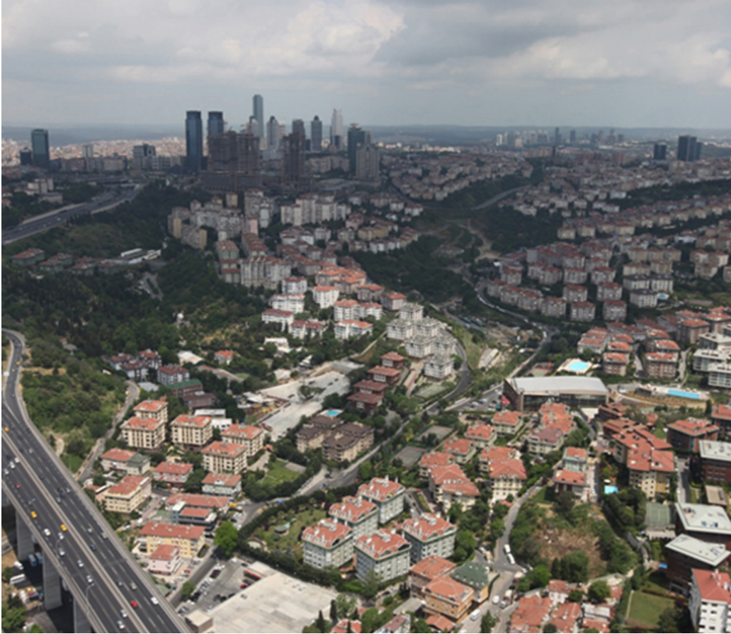
Şekil 6. Ortaköy Vadisi içerisinde gelişen çevrelenmiş konut alanlarının topoğrafik yapıda oluşturduğu deformasyon. Dolgu ve hafriyat alanlarıyla daralan vadi.
