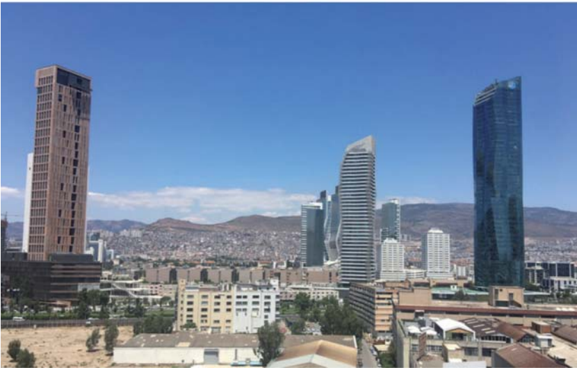
Şekil 6. İstanbul Zincirlikuyu-Maslak hattında (en üstte), Mersin’de (ortada) ve İzmir’de (en altta) çeper kuşak alanlarının alışveriş merkezleri, ofis ve konut alanlarına dönüşümü (Kişisel arşiv)
