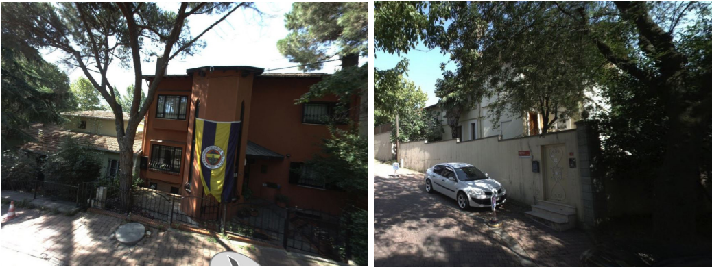
Şekil 15-16: Levent Mahallesi’nde Yapı-Yapı İlişkisi ve Yapıyı Sokaktan Soyutlayan Yüksek Bahçe Duvarları [4].
