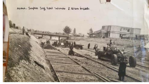
b. Sulama kanalının betonlanma süreci, Cemalpaşa Köprüsü ve Bağlar Karakolu inşaatı, 1960'lar.
