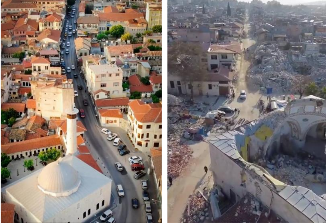
Şekil 9 Kurtuluş Caddesi 6 Şubat Depremi Öncesi (Sol, Kaynak: Url-2) ve Sonrası (Sağ, Kaynak: Url-3)
